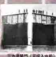
三池開門(完成入水前)
